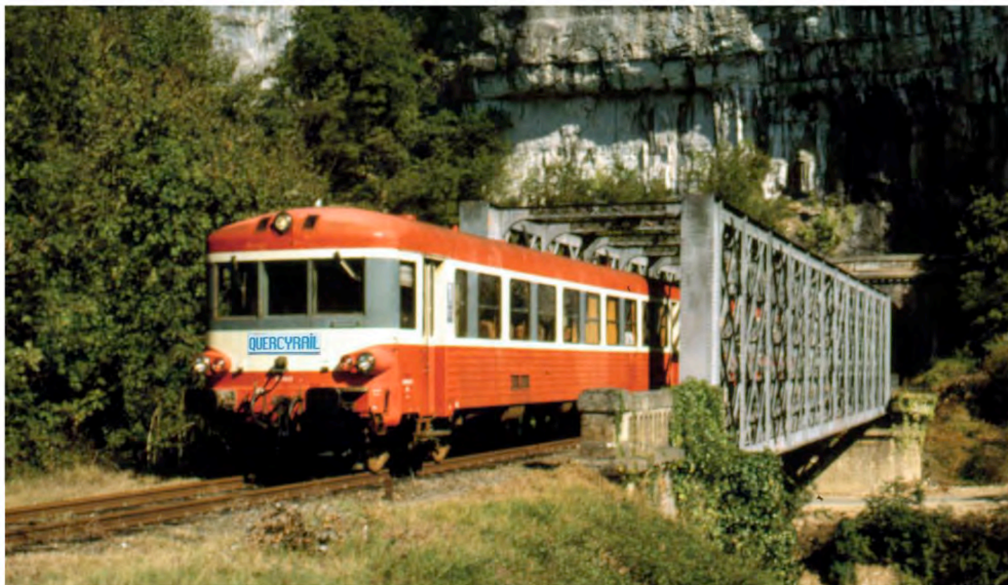
Ci-dessus, le train de Quercyrail franchissant le pont sur le Célé à l'entrée du tunnel de Coudoulous. Ci-dessous, le pont sur le Célé, dont les tours architecturales ont été détruites lors de l'explosion, et le tunnel.
